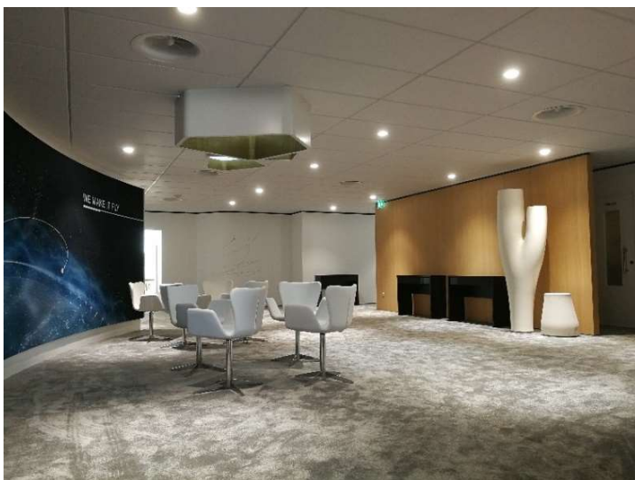
Mit Hilfe der Drallauslässe, wurde die Belüftungstechnik in das Design Konzept integriert
